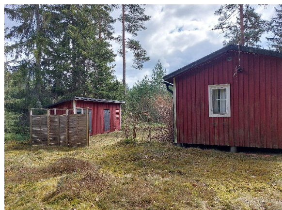
Figur 9: Obebott bostadshus med komplementbyggnad
