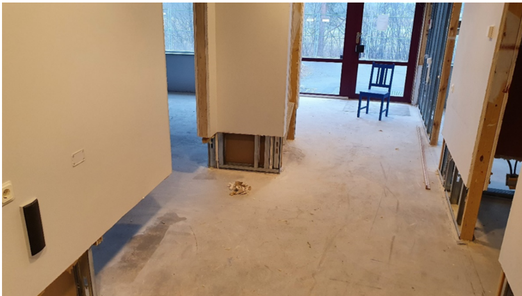
Bild: Slipat betonggolvs och avkapade fuktskadade innerväggar.
