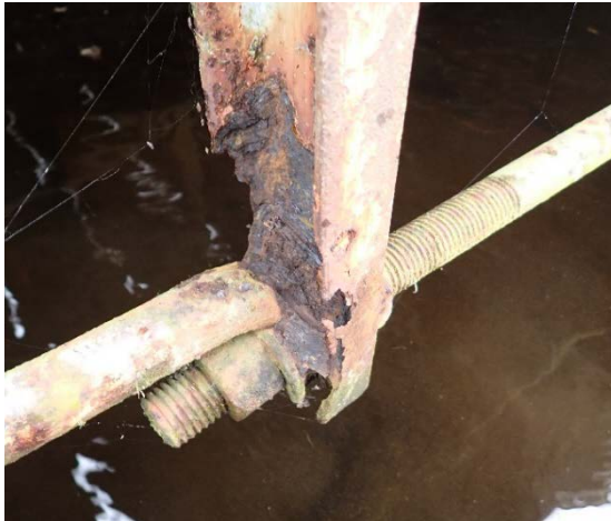
Bild 9 – Exempelbild av avrostning vid stagen.
