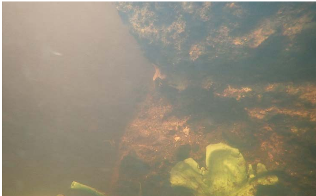
Bild 3 Visar gjutsår/gjutskarv på sydvästra hörnan.
