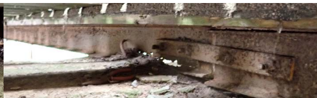
Bild 8 Visar avrostat liv på den inre balk vid mellanstödet.
