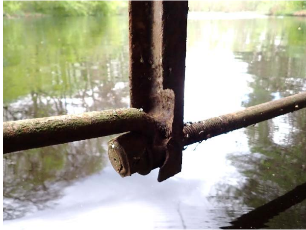
Bild 9 – Exempelbild av avrostning vid stagen.
