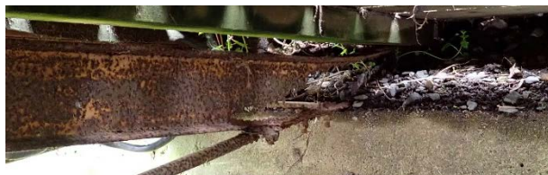
Bild 7 Visar avrostat liv på inre balk vid norra landfästet.
