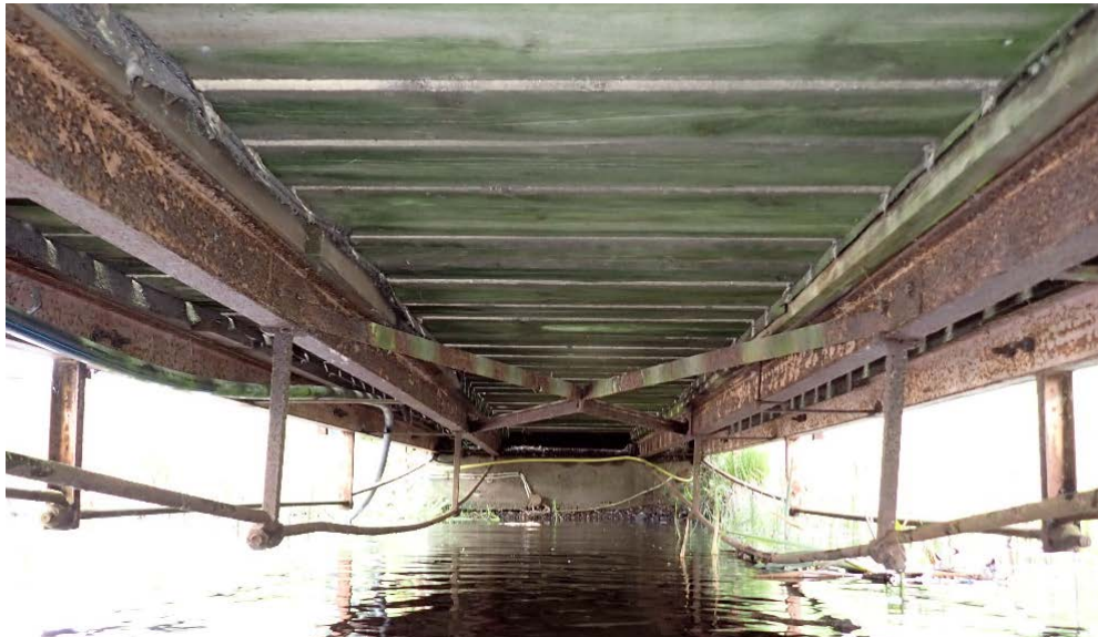
Bild 6 – Översiktsbild av undersida brobana.
