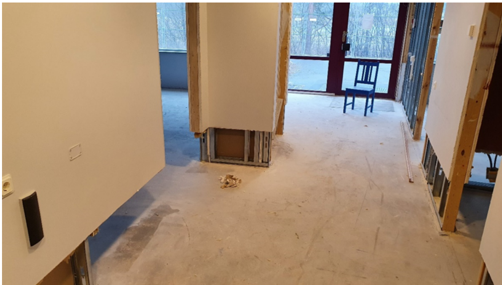
Bild: Slipat betonggolvet och avkapade fuktskadade innerväggar.
