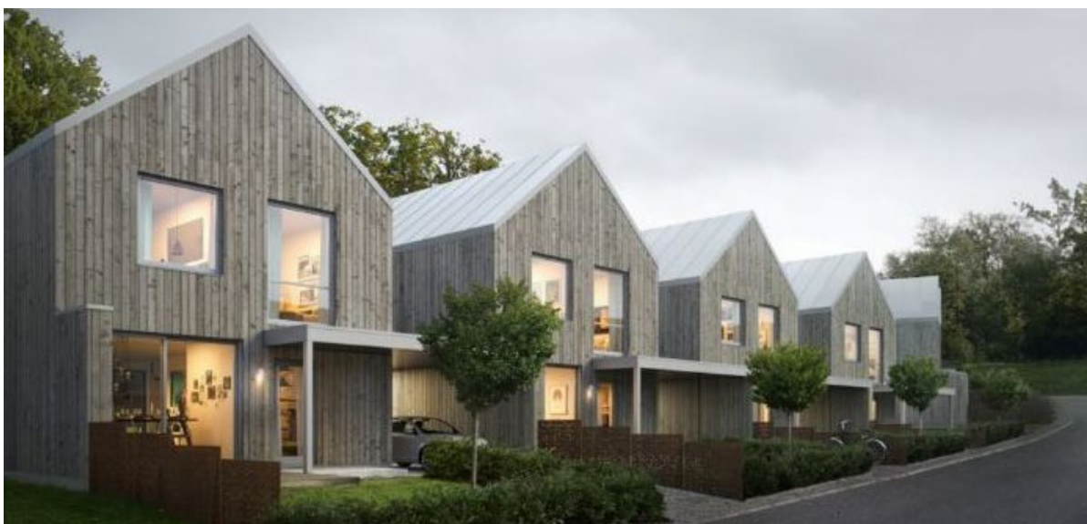
Exempel på kedjehusbebyggelse, silvergrå fasader med bandtäckta zinkfärgade sadeltak.
