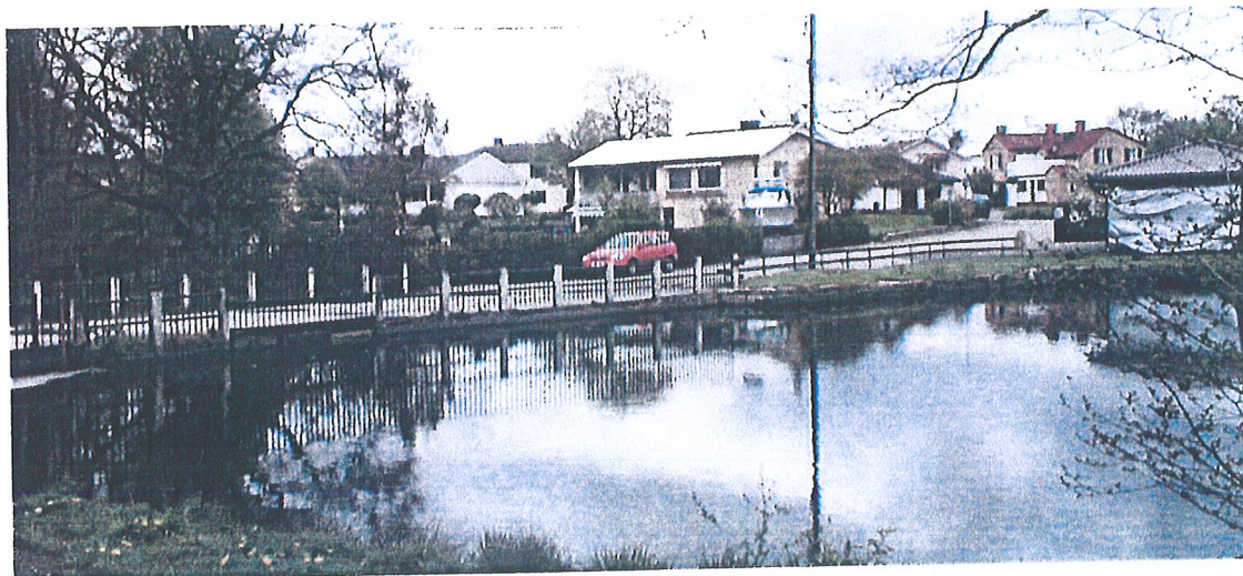
Bild 3.1. Bron sedd från uppströmssidan.
