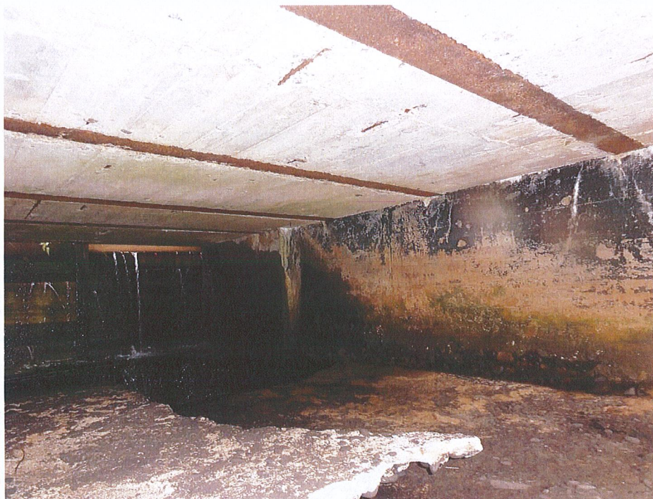
Bild 2: Blottlagd armering i broplattans underkant
