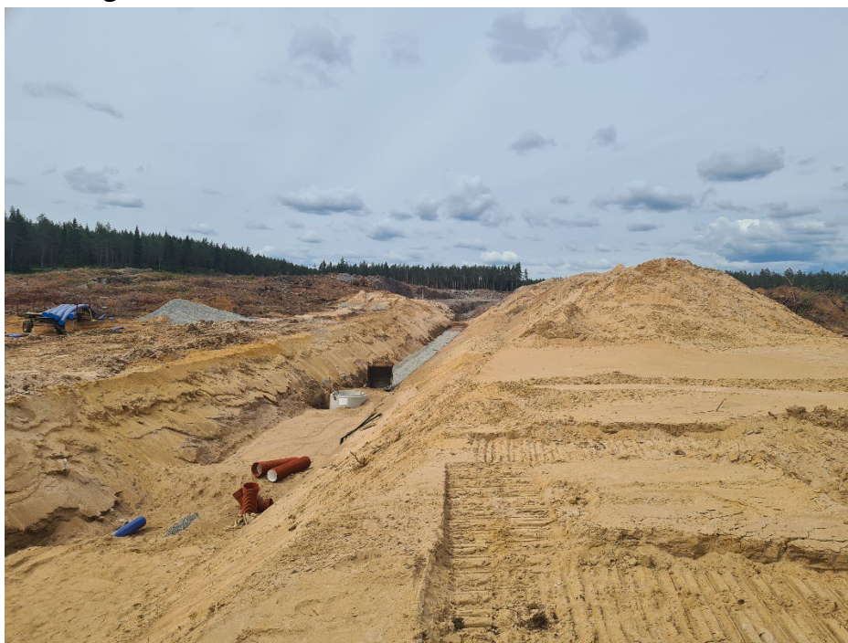
VA-schakt och gatuterrassering på exploateringsområde Stödstop 2:1 norr om travbanan
