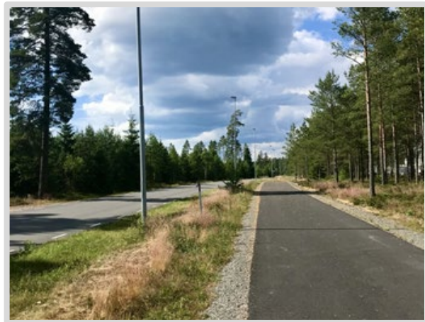
Gång- och cykelväg utmed Bondstorpsvägen (norrgående riktning).
