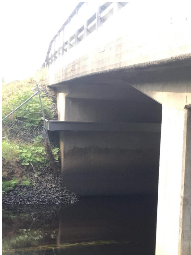
Bild 3. Bilden visar en utterpassage i form av en hylla som placerats längs broväggen där uttern kan passera.
