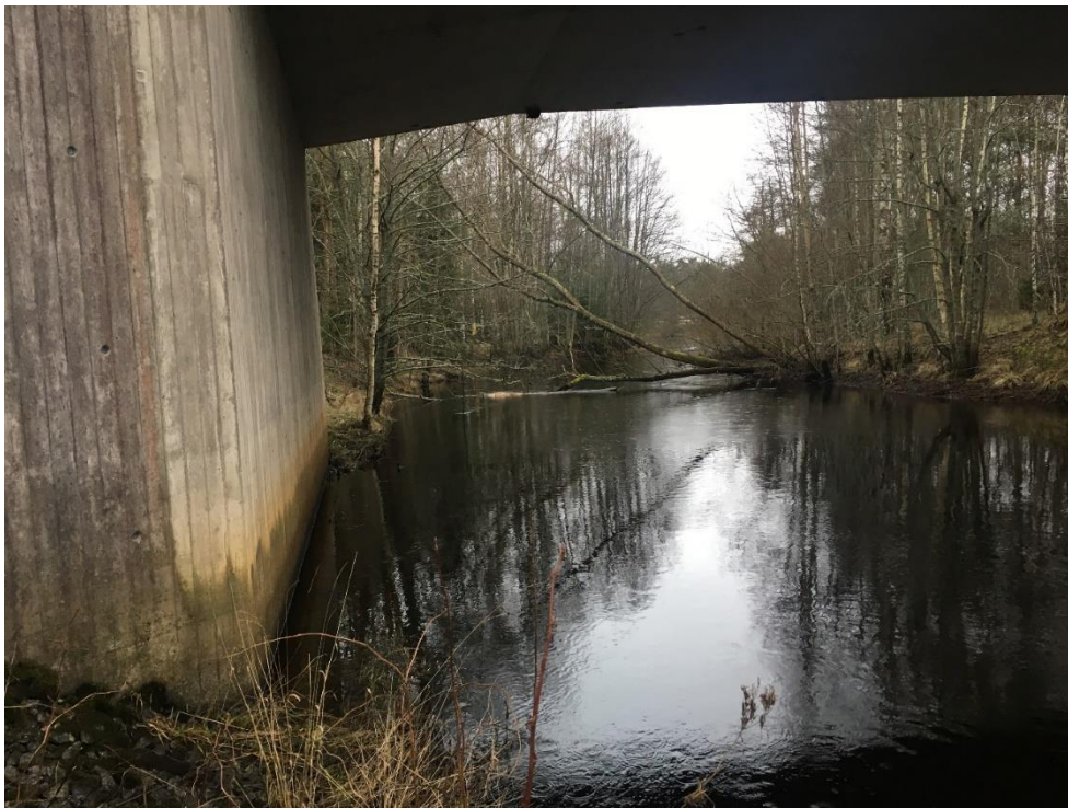
Bild 1. Fotot visar ett vandringshinder för utter. Broväggarna går rakt ner i vattnet och uttern kan inte passera på land under bron.
