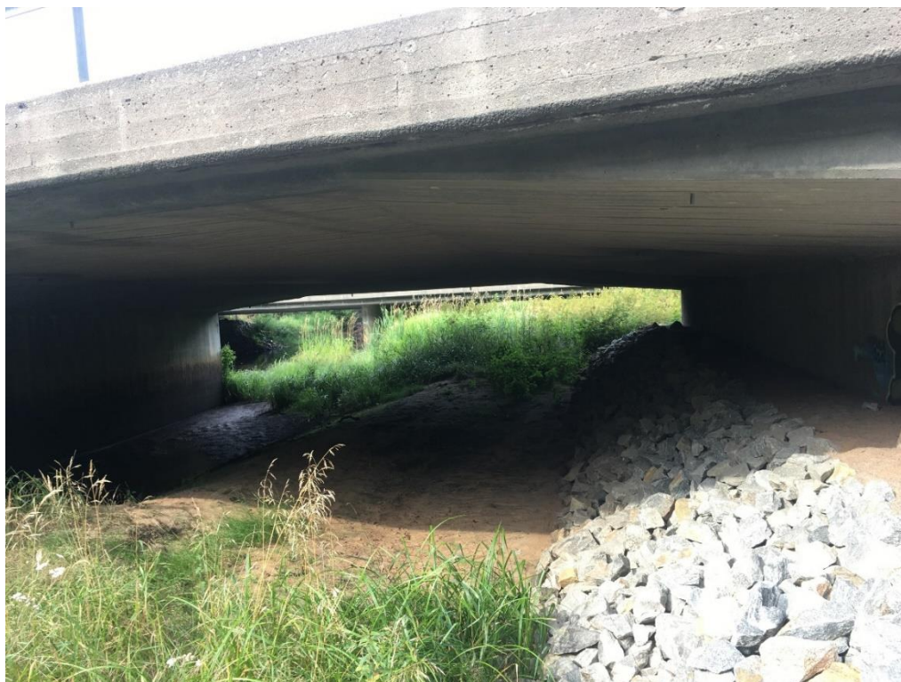
Bild 2. Fotot visar en bro där man har byggt en utterpassage med sten och sand längs med broväggen där uttern kan passera.
