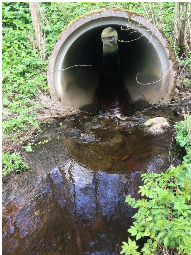
Bild 4 och 5. Det vänstra fotot visar en trumma där det är fall in i trumman och det högra fotot visar en trumma där det är fall in i trumman.
