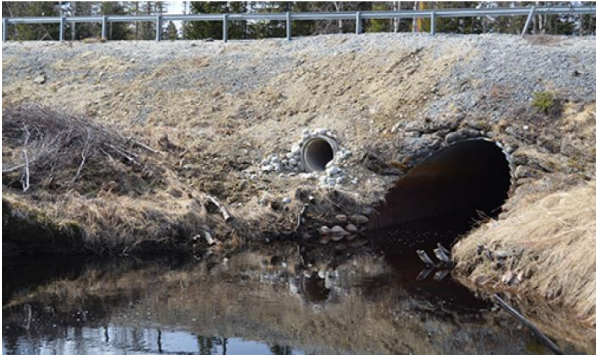
Bild 8. Fotot visar en vattenfylld trumma samt en torrtrumma där uttern kan passera. Foto Trafikverket.
