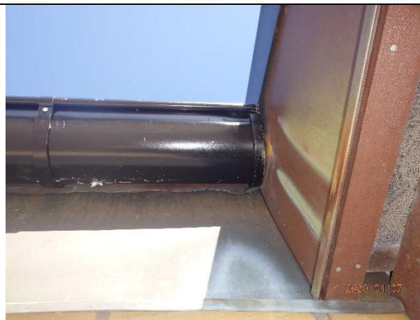
Ränngavel är sned monterad
