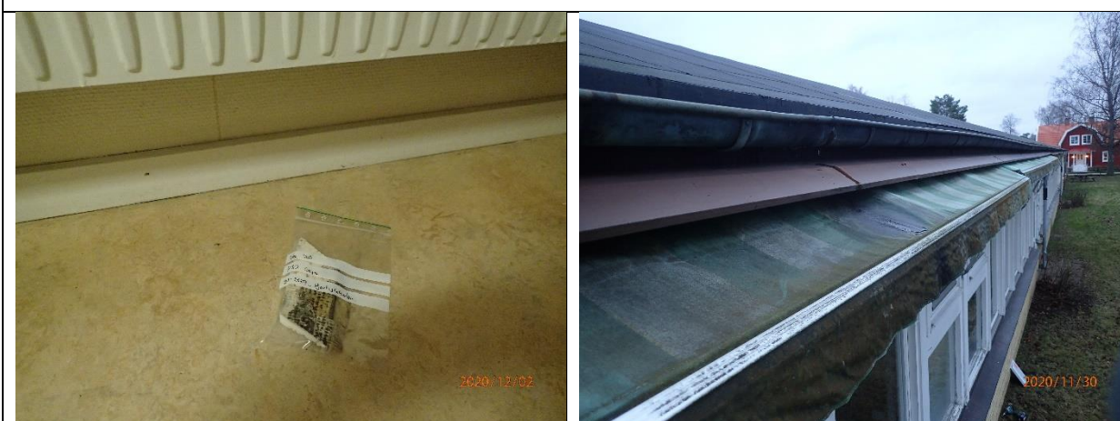
Prov 10, Gips i yttervägg rum 161 där det är en skarv på hänggränsen som läcker utvändigt.
