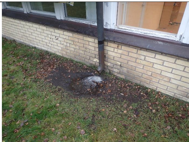
Takavvattning som slutar vid huslöv sitter utanför mellanvägg mellan rum 144 och rum 147.
