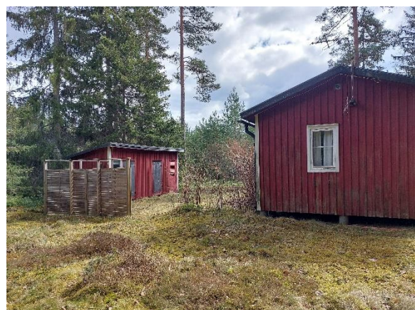
Figur 6: Obebott bostadshus med komplementbyggnad
