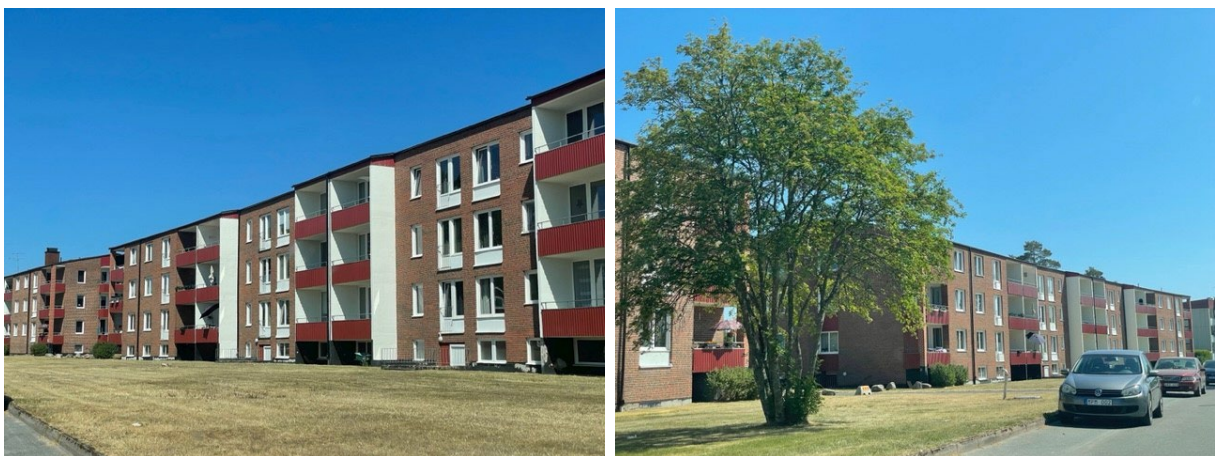
Befintlig bebyggelse inom planområdet som avser kvarteret Ålen.
