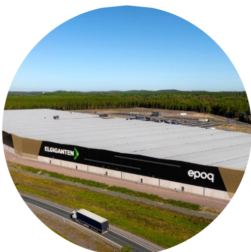
Referens: Epoq, Elgiganten. 80 000 kvm logistikbyggnad som bryts upp genom en knäckt volym och olika fasadmateriäl.
