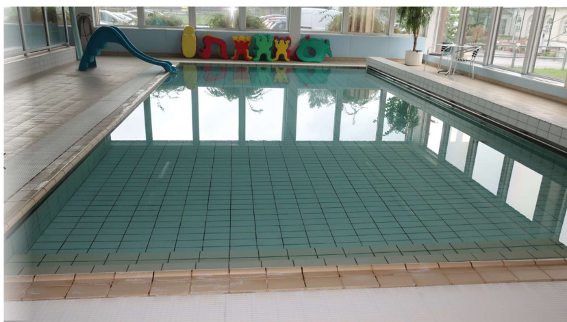
Fig 2.1-2 Vaggeryd Simhall – Undervisningsbassäng - översikt
