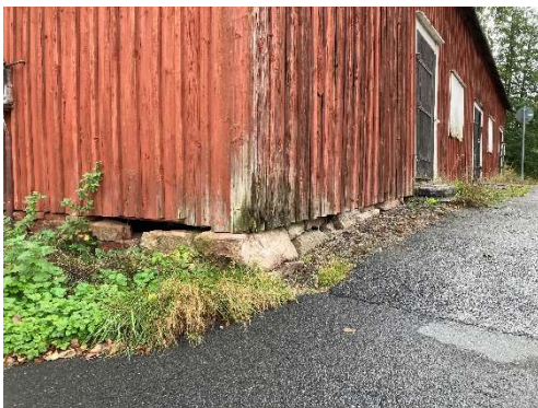
Marknivån utmed den västra sidan är hög. Här och var har stenar fallit ur grunden.
