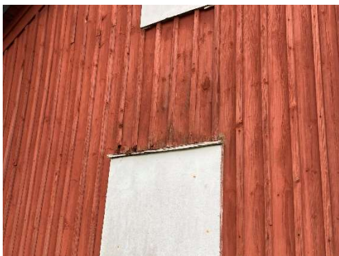
Det förekommer partiella skador på panel och vattbrädor.
