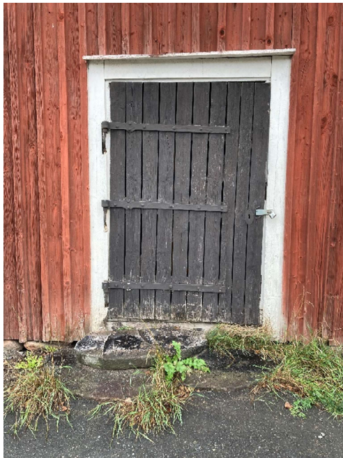
Samtliga dörrar är sentida, men med äldre återanvända beslag. Trappstenarna framför den norra dörren utgörs av kvarnstenar.
