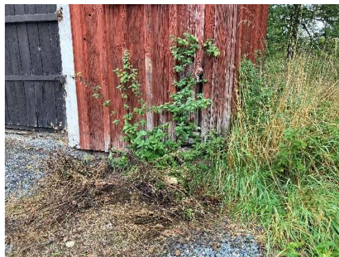
Det finns hög växtlighet nära byggnaden. Den bör tas ned och hållas efter.
