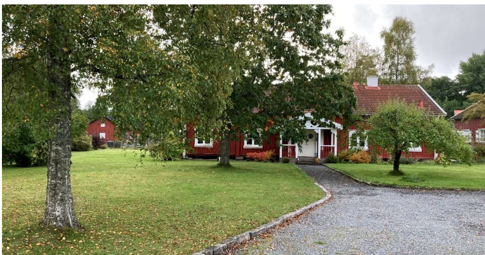
Den intilliggande f.d. förvaltarbostaden som tillsammans med järnboden utgör de enda kvarvarande byggnaderna från järnbruket. Järnboden skymtar till vänster på bilden.
