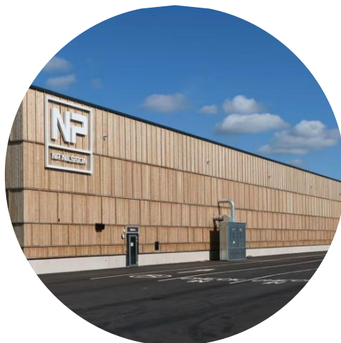
Indelning av fasad bryter ner byggnadens skala.
