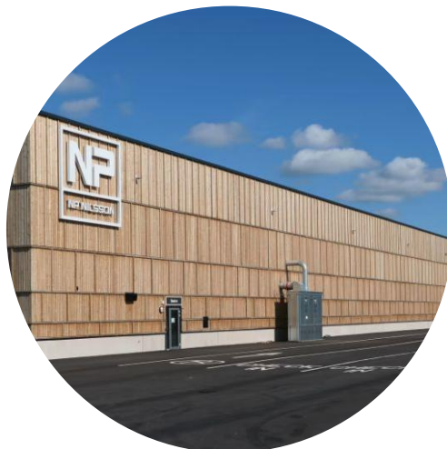
Indelning av fasad bryter ner byggnadens skala.
