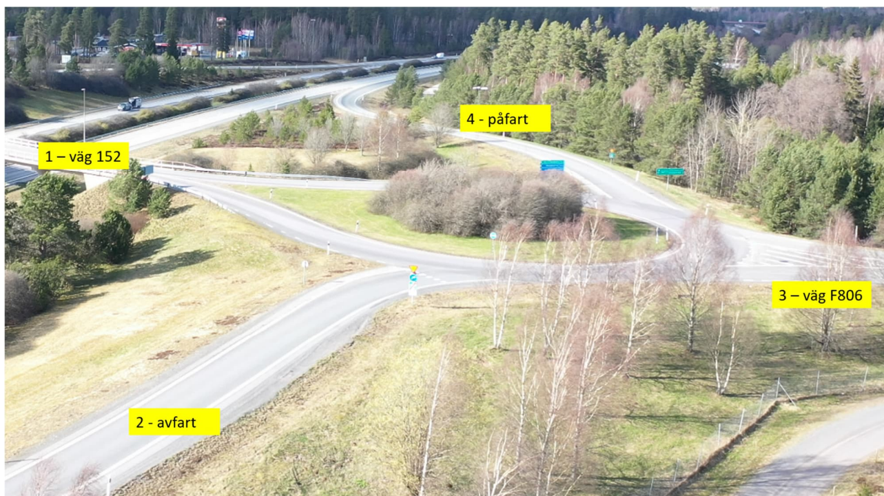
Figur 6 Korsningen C – väg 152 / F 806 / ramper östra sidan E4.
