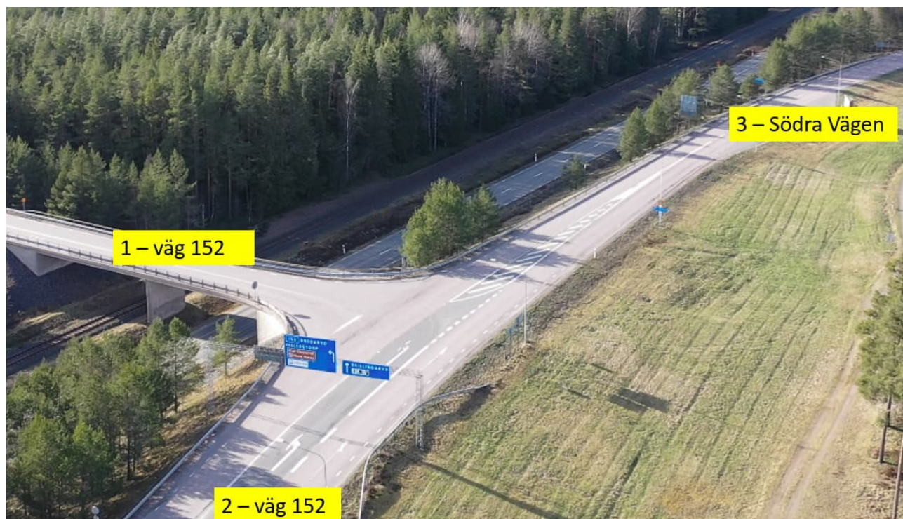
Figur 4 Korsning A – väg 152 / Södra vägen.
