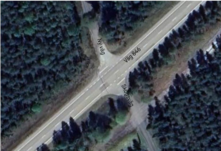
Figur 20 Placering och utformning för befintlig korsning mellan väg 846, ny väg och skogsväg.
