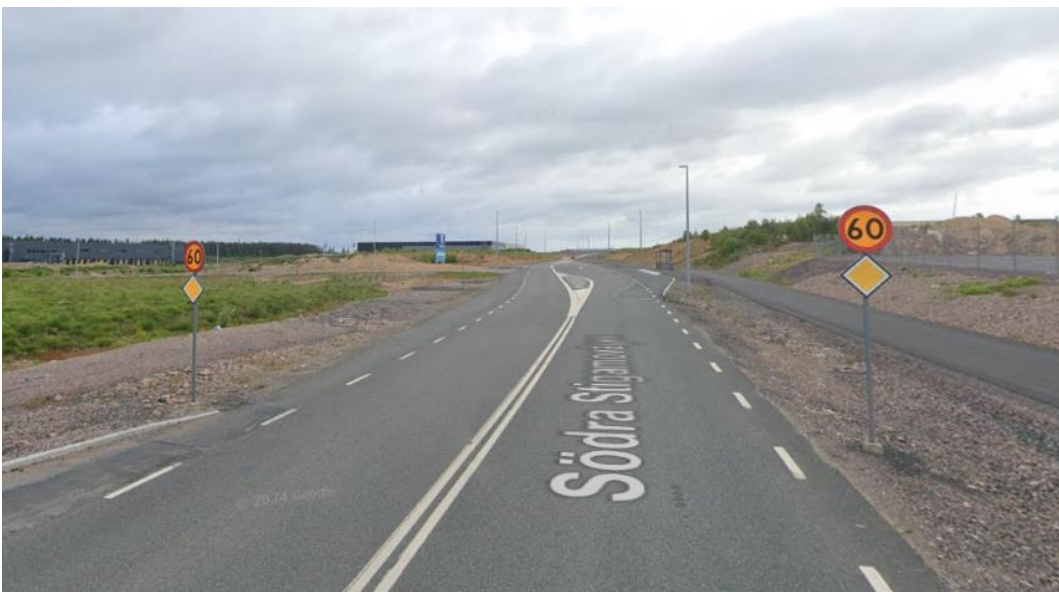
Figur 16. Södra Stigamovägen. Bild tagen norr om cirkulationsplats i korsning med Fraktvägen, i riktning norrut. Källa: Google Maps.
