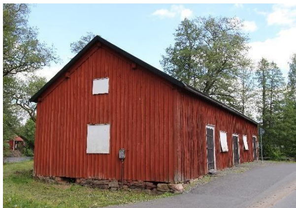
Järnboden i Götafors, Vaggeryd. Byggnad med kulturhistoriska värden.
