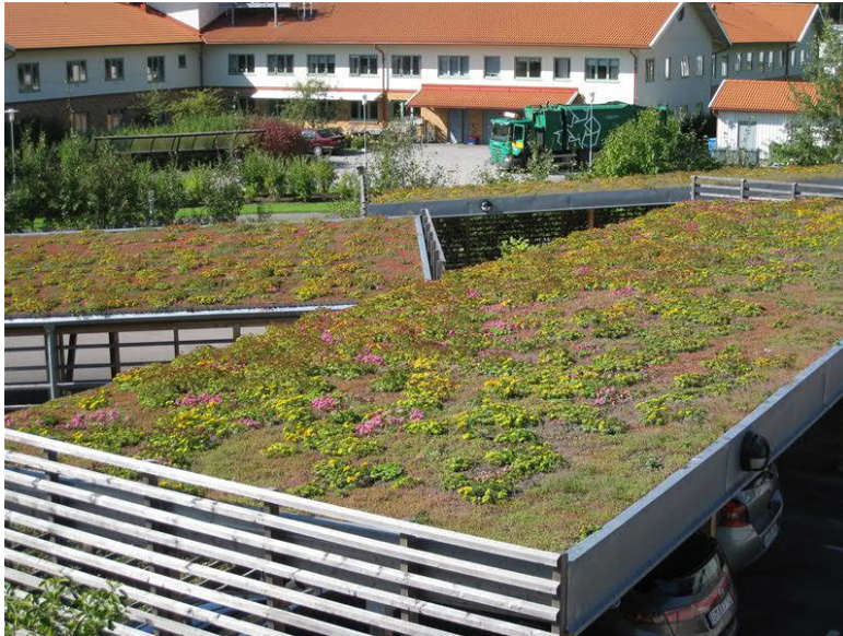
Figur 21. Grönt sedumtak på garagebyggnad i Kungsbacka. Bildkälla: VegTech AB.
