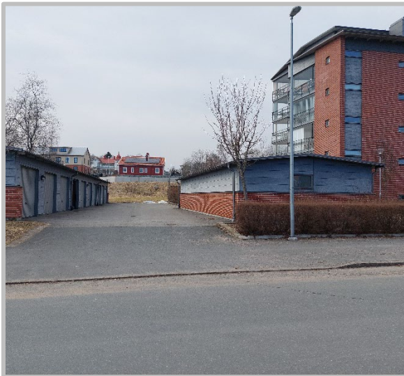
Figur 8: Befintligt punkthus och tillhörande komplementbyggnader.
