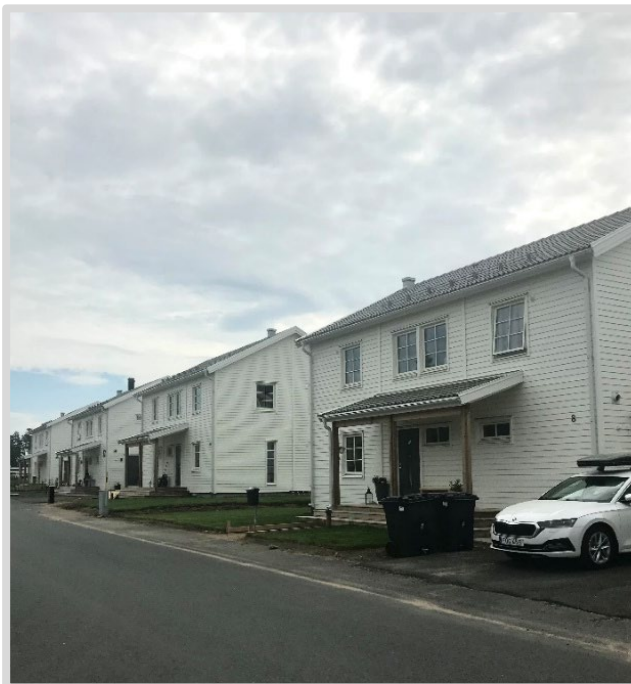
Parhus i Västra Strand utmed Kaveldungsgatan, öster om Bondstorpsvägen.
