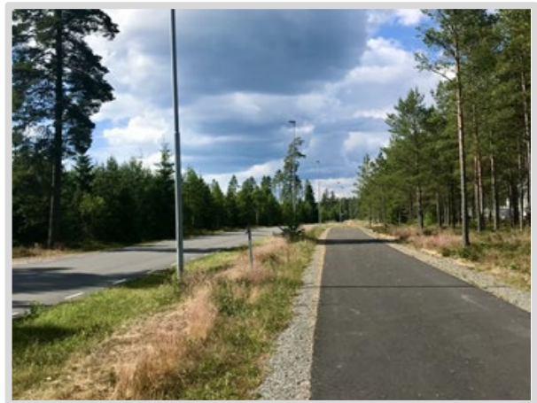
Gång- och cykelväg utmed Bondstorpsvägen (norrgående riktning).
