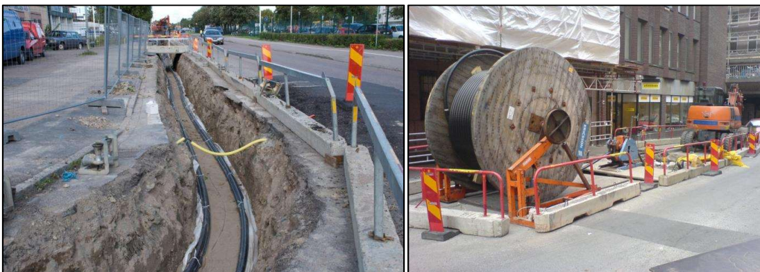
Figur 3. T.v. schakt i stadsmiljö i vägbana. T.h. exempel på arbetsområde i stadsmiljö.
