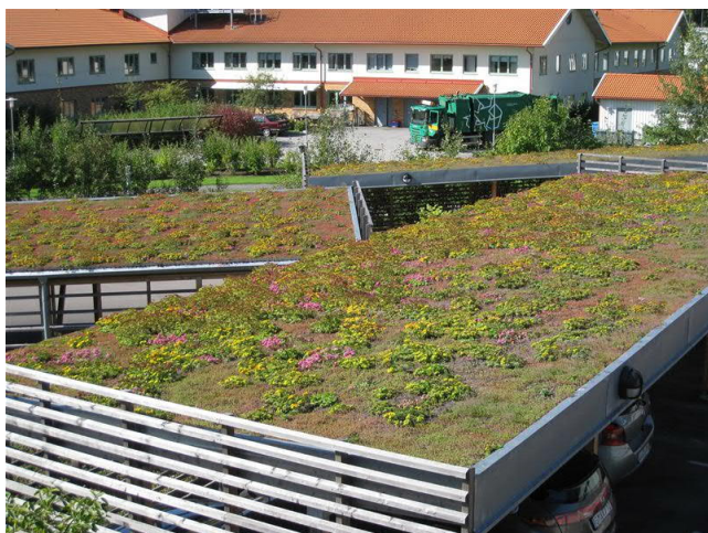
Figur 20. Grönt sedumtak på garagebyggnad i Kungsbacka. Bildkälla: VegTech AB.
