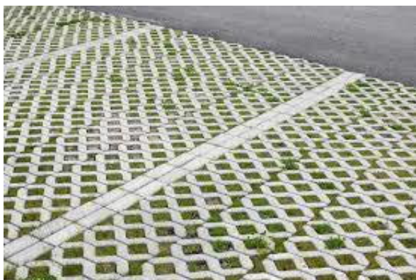
Figur 19. Exempel på parkering med raster av betong. Bildkälla: Sweco
