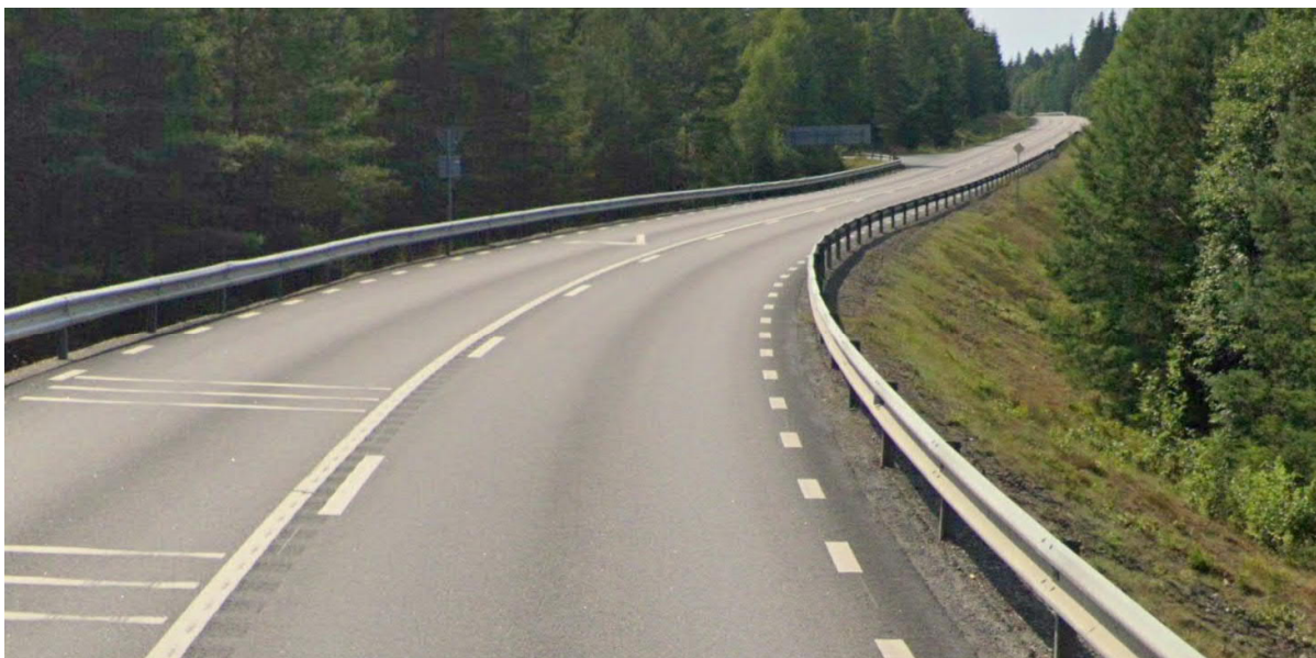
Figur 14 Vy åt väster längs väg 152 från närmast väster om bron över järnvägen. Nuvarande korsning in mot det planerade exploateringsområdet syns halvvägs bort i bilden. En placering av korsningen i ungefär det läget rekommenderas eftersom sikten här bedöms vara bäst, samtidigt som korsningen hamnar relativt långt ifrån korsningen med Södra vägen.
