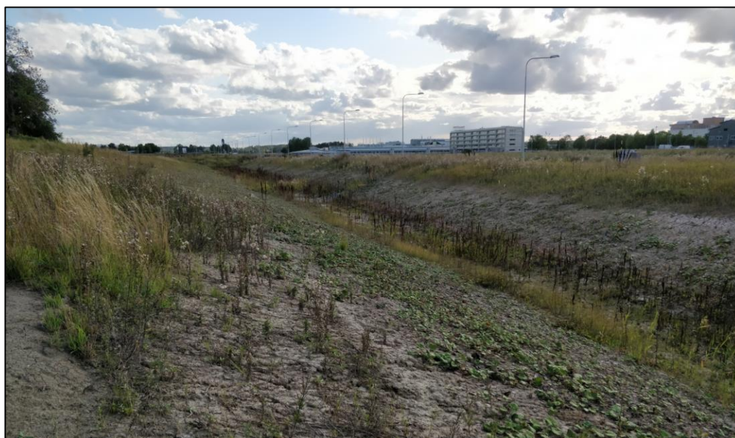
Figur 18. Exempelbild på svackdike (Foto: Sweco).
