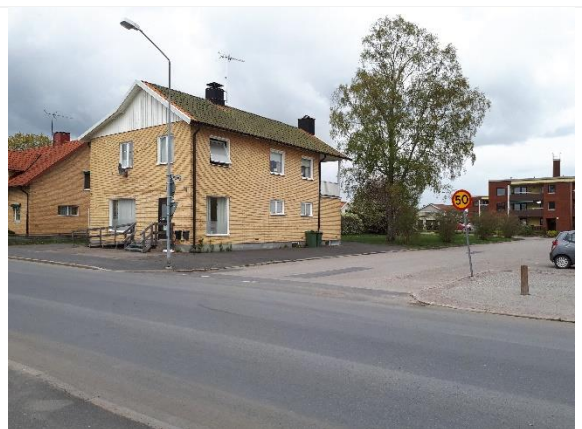
Befintlig bebyggelse inom fastigheten Dalhem 1
