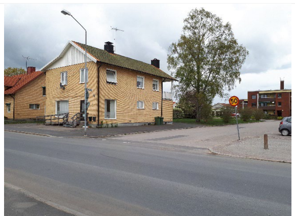
Befintlig bebyggelse inom fastigheten Dalhem 1
