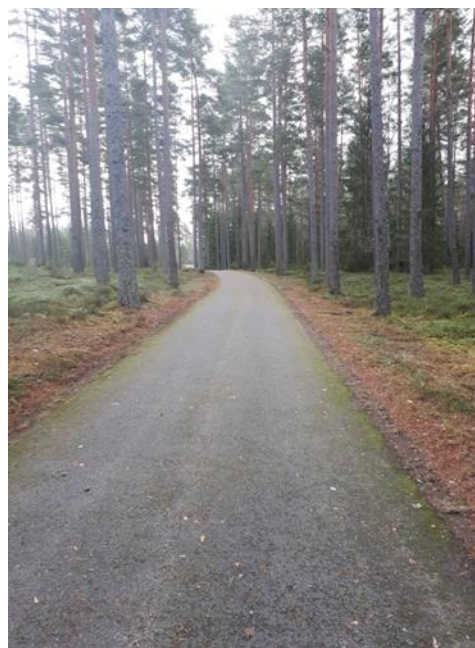
Figur 8: Befintlig gång- och cykelväg utmed planområdets östra del.
