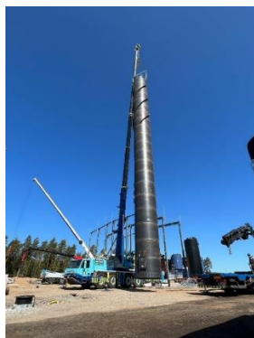
Uppförande av skorsten vid byggnation av nytt fjärrvärmeverk.
