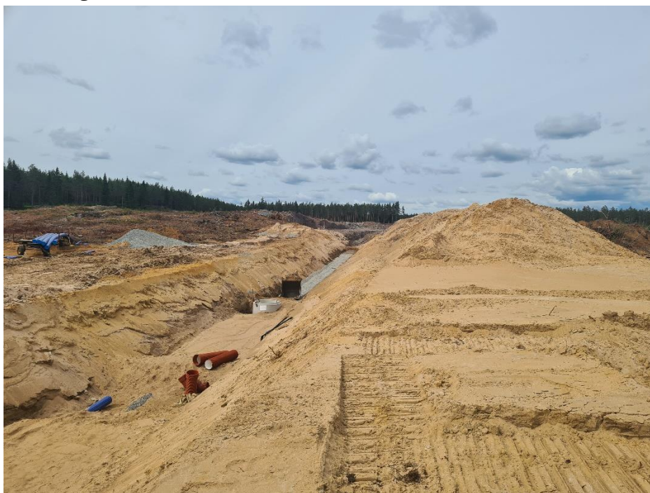
VA-schakt och gatuterrassering på exploateringsområde Stödorp 2:1 norr om travbanan
