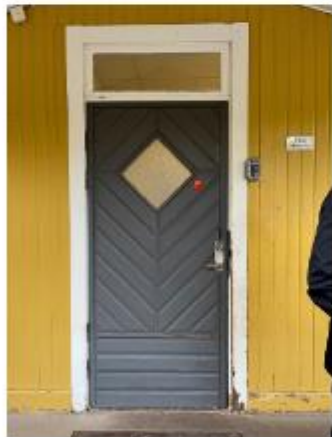
Byte av entrédörr. Dörr och lodde som är mer tidstypiska för byggnaden.
