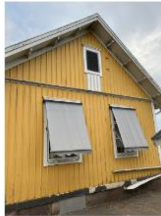
Utvändiga markiser demonteras.
