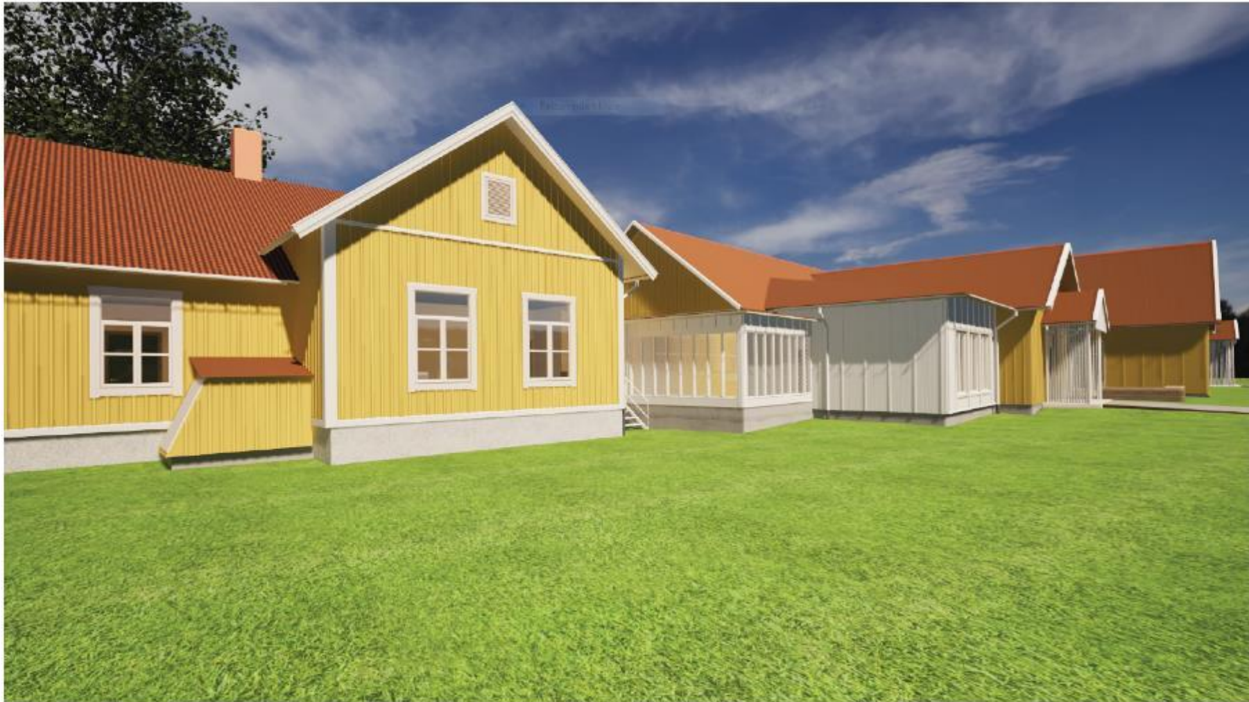
Gamla skolbyggnaden i förgrunden, tillbyggnad i bakgrunden.
