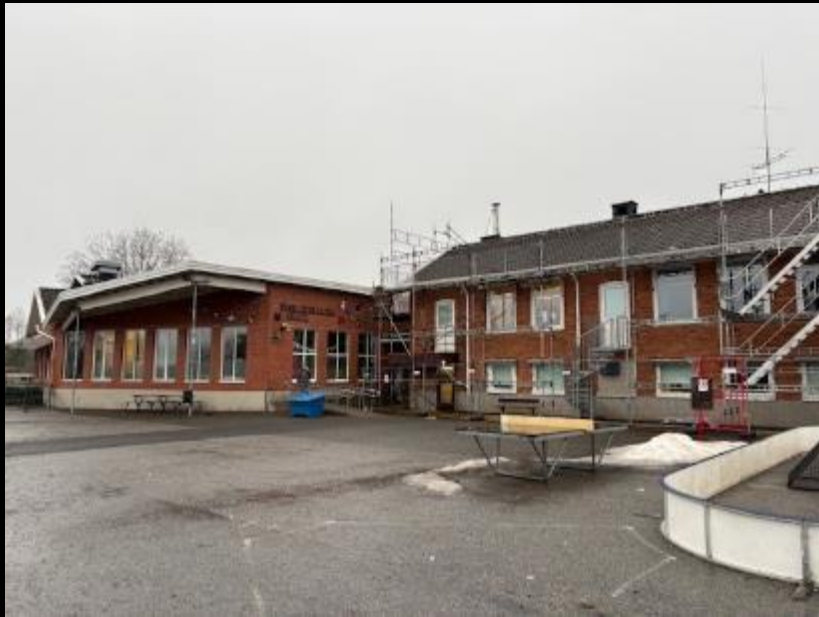
Yttertaket byts ut
