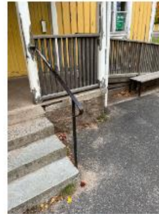
Renovering av pelare till skärmtak. Byte av räcke till mer tidsenligt. Ny ramp. Lagning av betongplattform.
