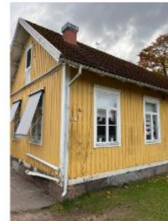
Generell renovering av tak. Byte av lakpannor. Ersätt med lagapannor. Byte av taktepp och läsk. Byte av stuprör och hängrännor. Byte av takstickerhållare.
