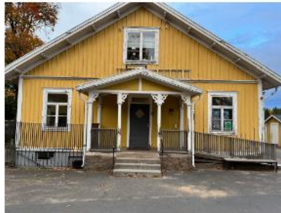
Renovera befintliga träfönster. Byte av foder och droppblock.
