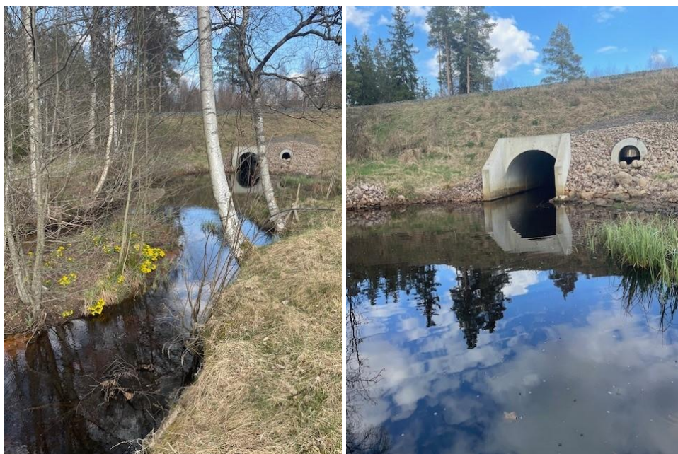
Figur 20. Linnarebäcken korsar järnvägen genom bantrumma under järnvägen (foton visar utlopp). Strax intill har en torrtrumma installerats.
